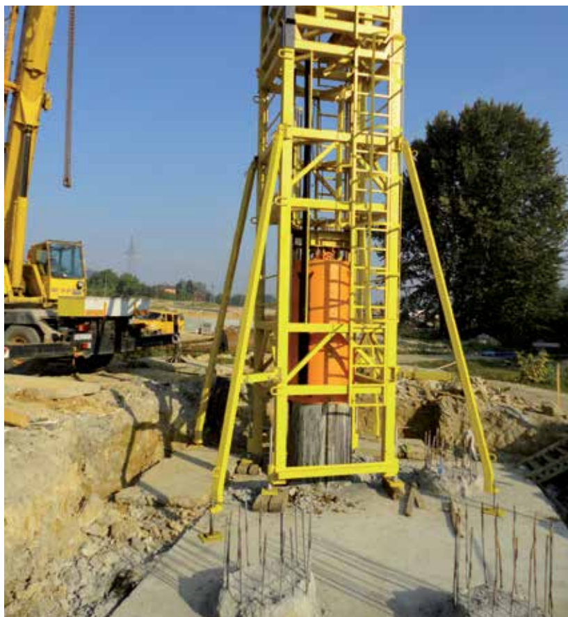
BUDOWA DROGI EKSPRESOWEJ S69 ODC. BIELSKO-BIAŁA-ŻYWIEC. STANOWISKO DO PRÓBNEGO OBCIĄŻENIA DYNAMICZNEGO WIELKOŚREDNICOWYCH PALI WIERCONYCH
