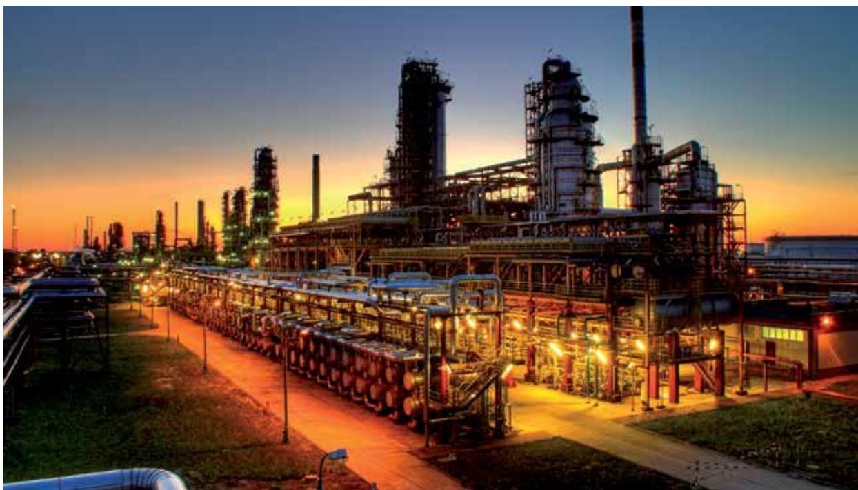
BŁOK GAZOWO-PAROWY, PŁOCK
