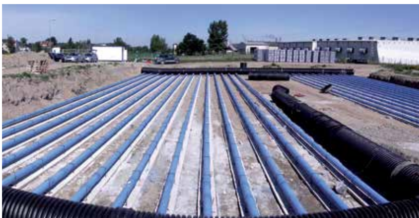
MONTAŻ GRUNTOWEGO POWIETRZNEGO WYMIENNIKA CIEPŁA REHAU, BIUROWIEC PASYWNY W NYSIE
