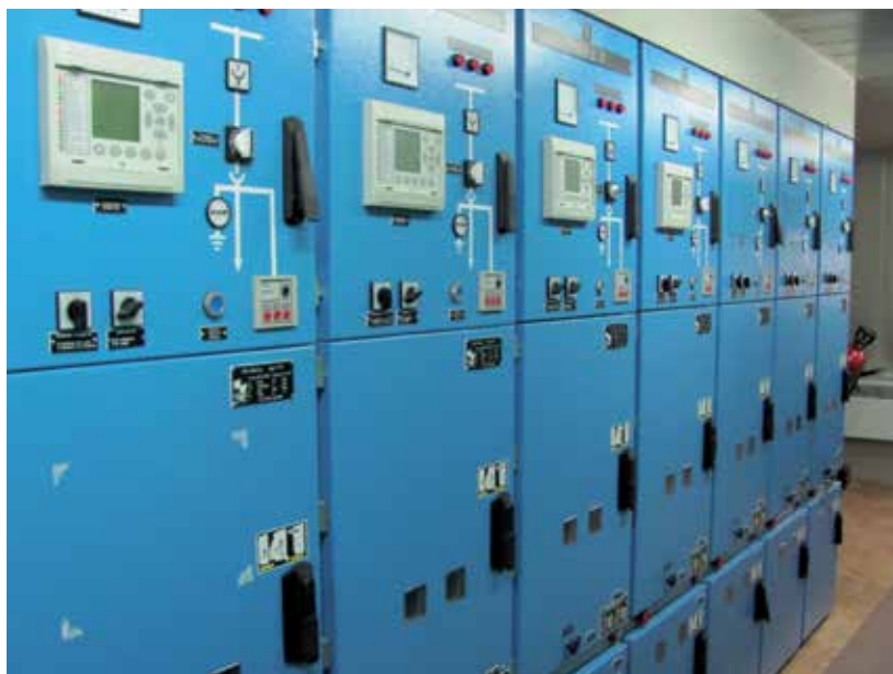
ROZDZIELNIA ELEKTROENERGETYCZNA GPZ PŁOŃSK
