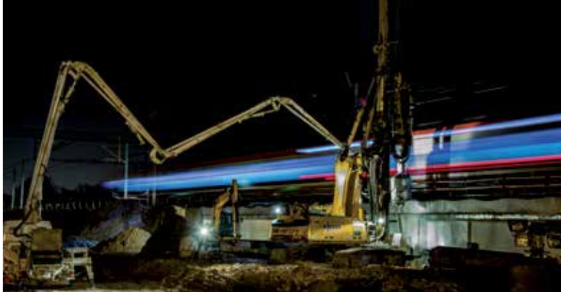
PALE WIERCONE, ŁĄCZNICA KOLEJOWA, KRAKÓW
