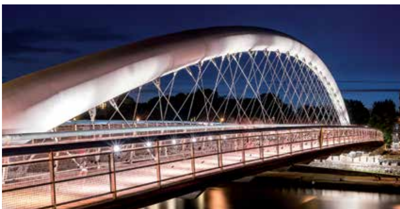
KŁADKA BERNADKA W KRAKOWIE
