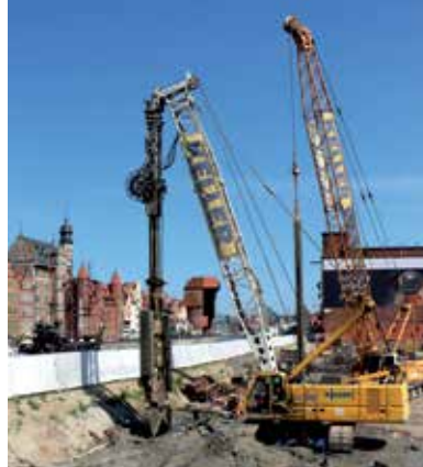
ŚCIANY SZCELINOWE, GDAŃSK
