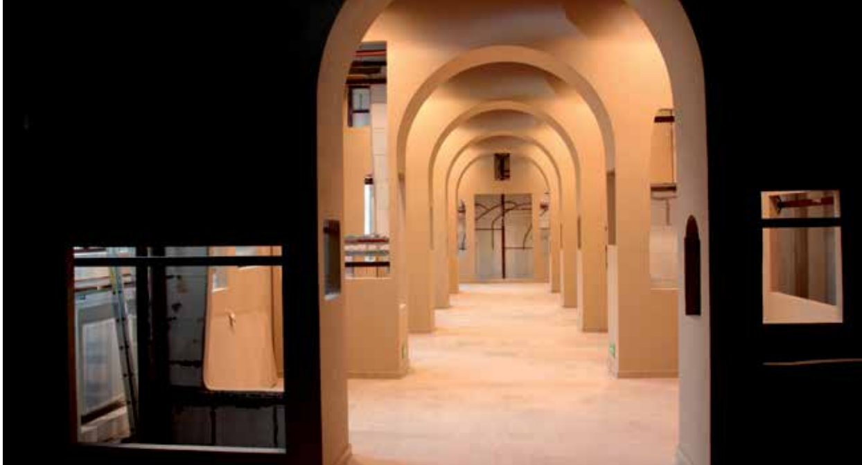
GALERIA FARAS, MUZEUM NARODOWE W WARSZAWIE. Wykonanie repliki wczesnochrześcijańskiej katedry z Faras we wnętrzu Galerii MNW. Wyjątkowa konstrukcja utrzymująca lekkie ściany, imitujące kamienne wnętrza historycznej budowli. Odtworzenie podłóg z kamiennych płyt. Oryginalny system wsporczy dla fresków i elementów zabytkowych. Realizacja oświetlenia ekspozycyjnego i klimatyzacji Galerii.
